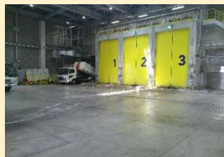
可燃棟プラットフォーム
